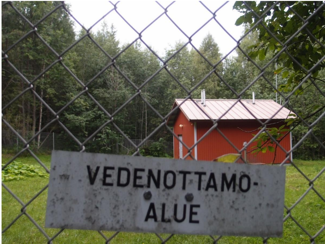
Kuva 10 a ja b. Vedenottamorakennukset Saukkovaaralla.
