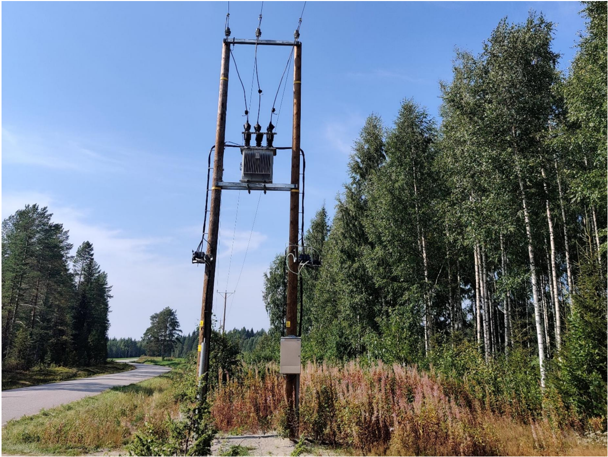
Kuva 16. Pylväsmuuntamo Lahnasenharjun pohjavesialueella.
