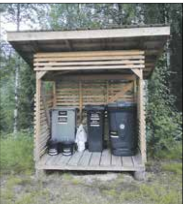
Hiisijärven kylätalon pihalle raken- nettiin talkootyönä jätekatos.
