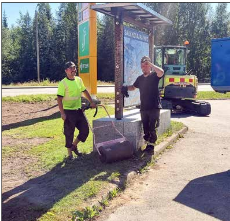
Mäntytien risteyksen hulevesiongelman korjaustyö S-marketin luona on saatettu päätökseen Kainuun Konetyön ammattilaisten voimin.
