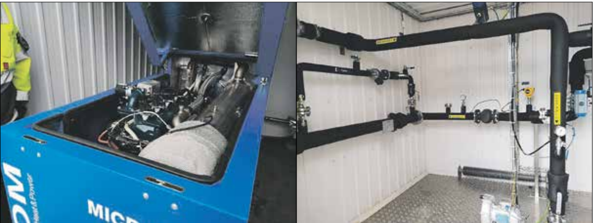
Generaattori, joka toimii biokaasulla. Päästötön!
