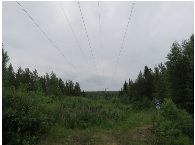
Kuva 23. Voimalinjakäytävä Alatalon kohdalla, pohjoiseen.
