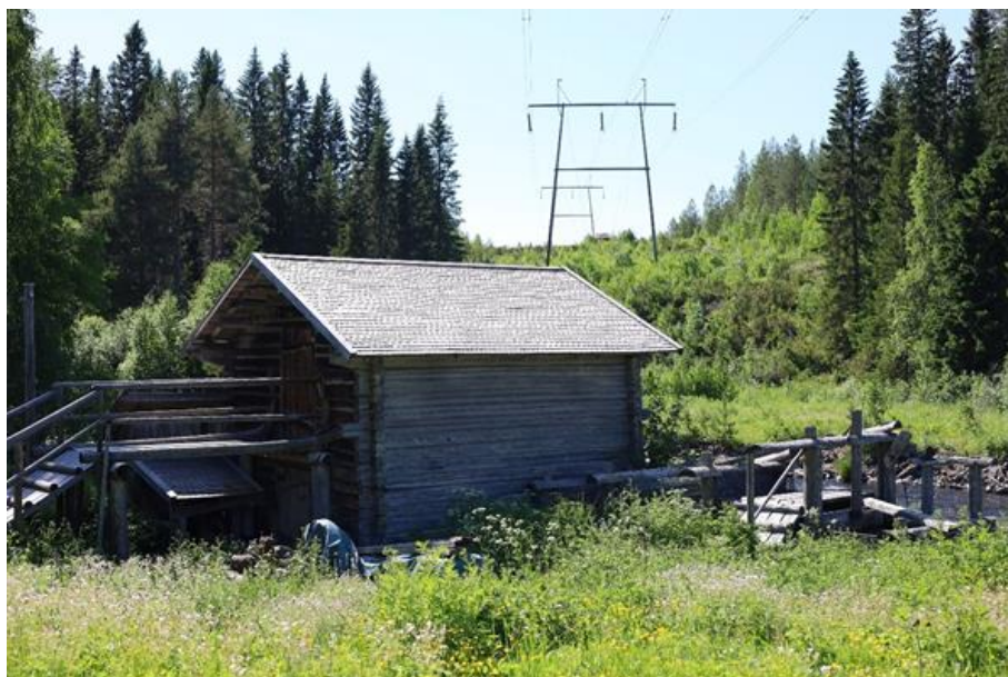
Kuva 4-17. Karppalan turbiinimylly sijaitsee Torvenjoen varrella lähellä Uvantietä. Kohteen ylitse kulkee 220 kV voimalinja.
