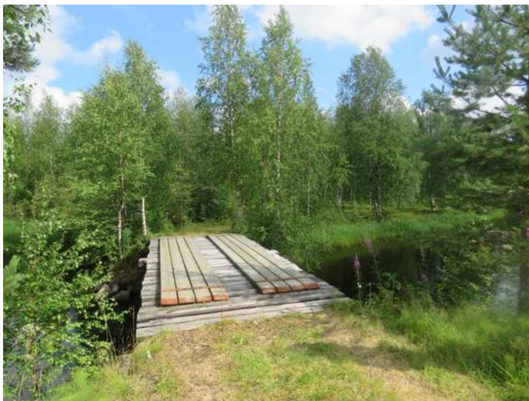
Kuva 8. Silta Ritosaarelle kuvattuna itään.
